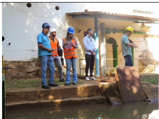
Autor: AMAE/RIO VERDE Descrição: Tratamento preliminar por gradeamento fino.
