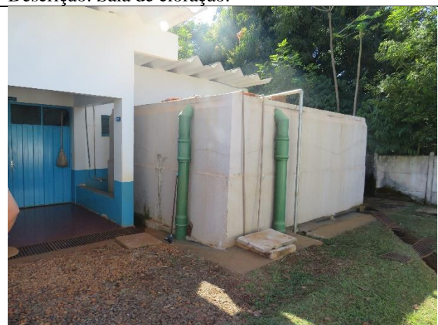
Autor: AMAE/RIO VERDE Descrição: Tanque de contato.
