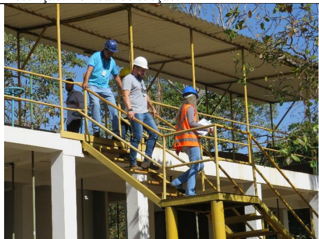
Autor: AMAE/RIO VERDE Descrição: Estrutura de localização dos filtros Russo.
